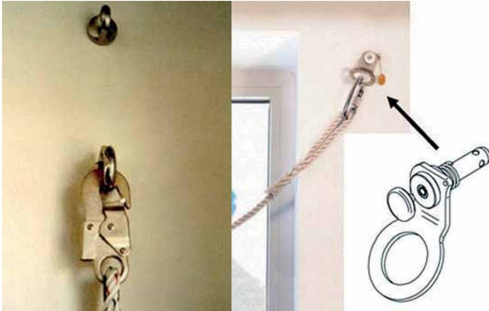
Bild 27: Beispiele für eine Anschlageneinrichtung der Klasse A (Ringösen)
