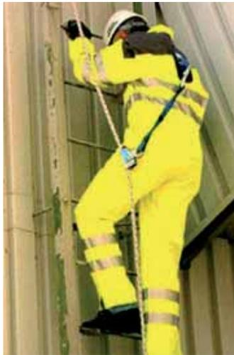
Der Auffanggurt wird durch ein Verbindungselement oder ein Verbindungsmittel mit angefügtem Verbindungselement mit dem mitlaufenden Auffanggerät verbunden. Im Sturzfall arretiert das mitlaufende Auffanggerät an der beweglichen Führung und hält die zu sichernde Person.
