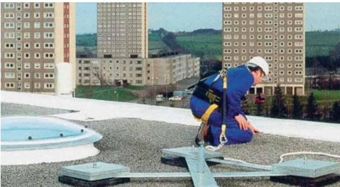
**Bild 32:** Durch Eigengewicht gehaltene Anschlageinrichtung (z.B. Betongewichte)
