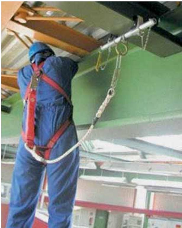
Bild 28: Beispiel für eine Anschlageneinrichtungen der Klasse B - Trägerklemme
