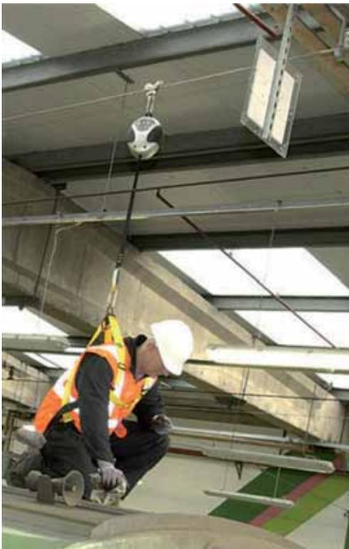
*Hinweis:* Die Funktion des Höhensicherungsgerätes kann durch das Nachgeben der Seilführung der Anschlagereinrichtung beim Aufgangvorgang beeinträchtigt werden. Deshalb ist vor der Benutzung eines Höhensicherungsgerätes an einer Anschlagereinrichtung der Klasse C sicherzustellen, dass das Höhensicherungsgerät für diese Verwendung geeignet ist. Angaben hierzu sind der Gebrauchsanleitung des Höhensicherungsgerätes zu entnehmen.
